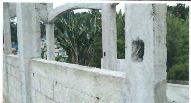
Foto 6: Aulas sin conexión eléctrica
